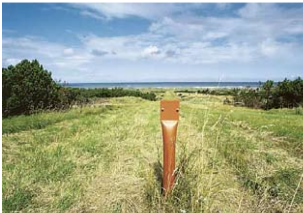
Återställd åker efter kabeldragning till den danska havsbaserade vindkraftparken Horns Rev.
