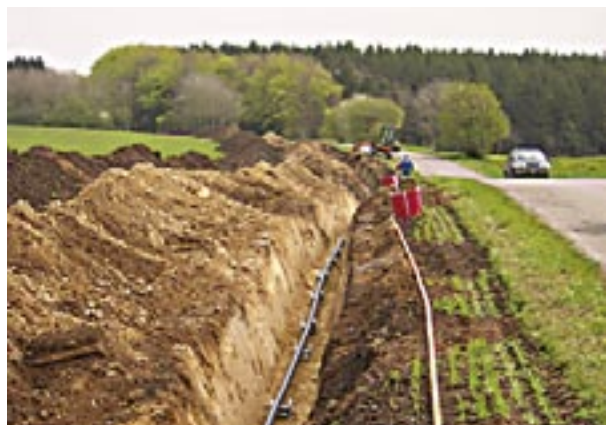
Exempel på kabeldragning vid väg.
