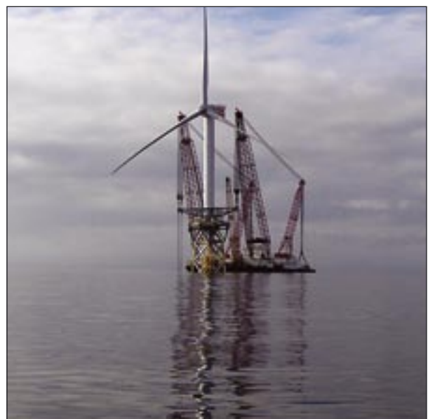
Anläggningsskede av havsbaserat vindkraftverk då Repower 5M installeras i en pilotanläggning utanför Skotland sommaren 2006. Foto: Copyright RePower
