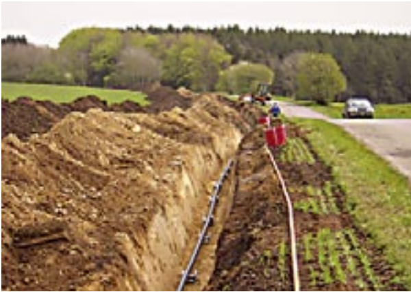
Exempel på kabeldragning vid väg.
